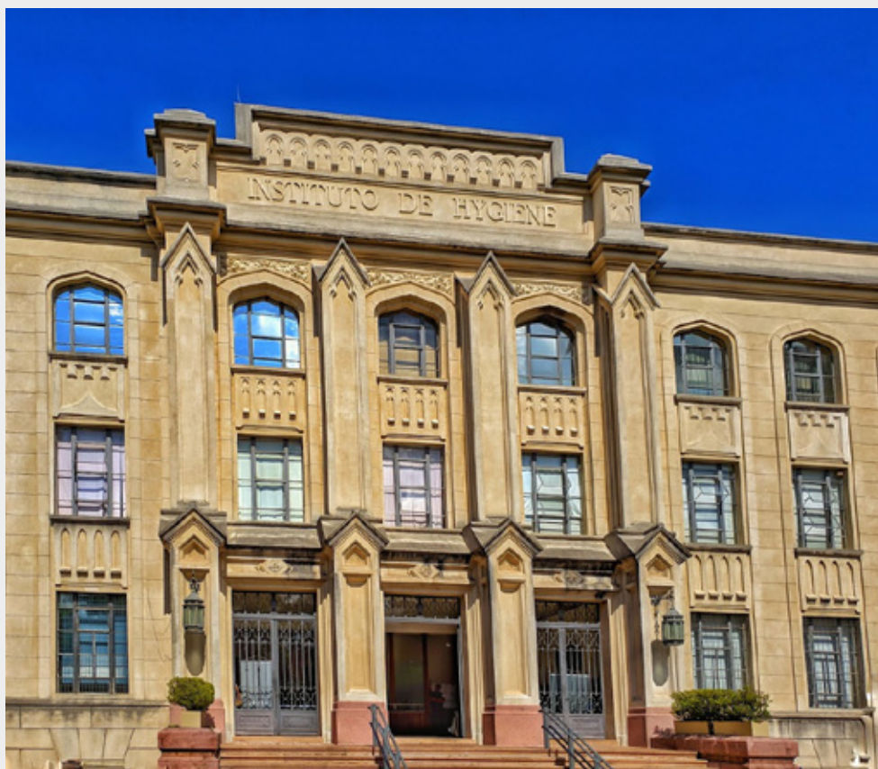
Foto: Faculdade de Saúde Pública da USP, que ainda mantém na fachada sua designação original.
